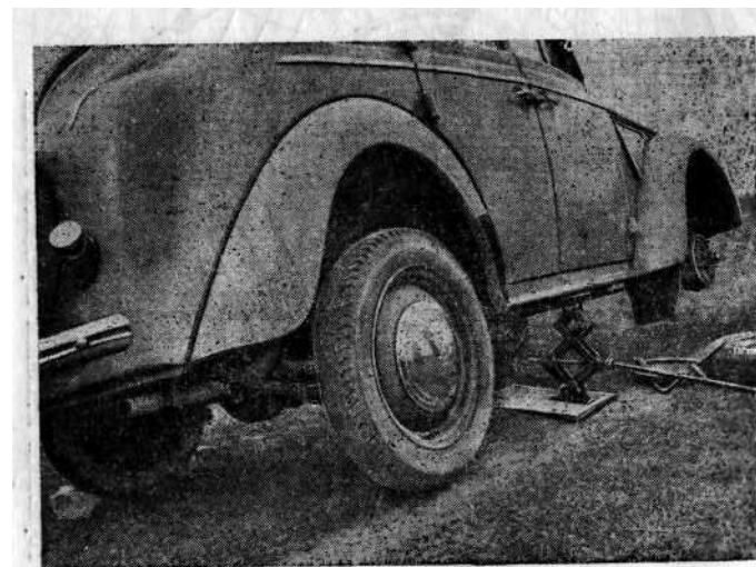
Фиг. 96. Поднятие домкратом одной стороны автомобиля.
